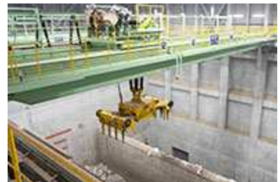
高座清掃施設組合処理施設
