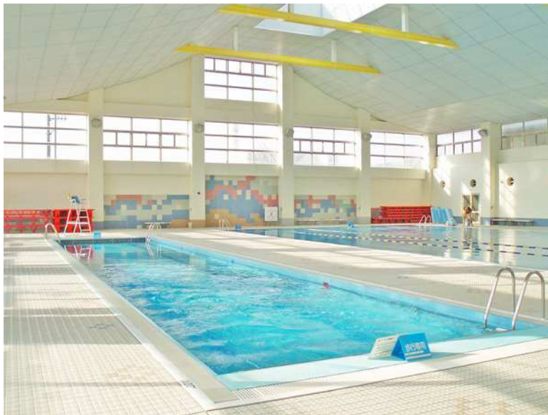
高座清掃施設組合温水プール
