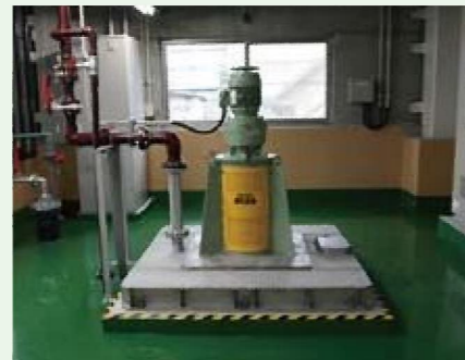
1F/曝気装置 曝気攪拌により、汚れ・臭いの成分を低減します。
