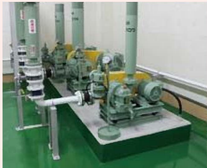
B1F/ブロワ 水槽内へ空気を効率的に送り込みます。
