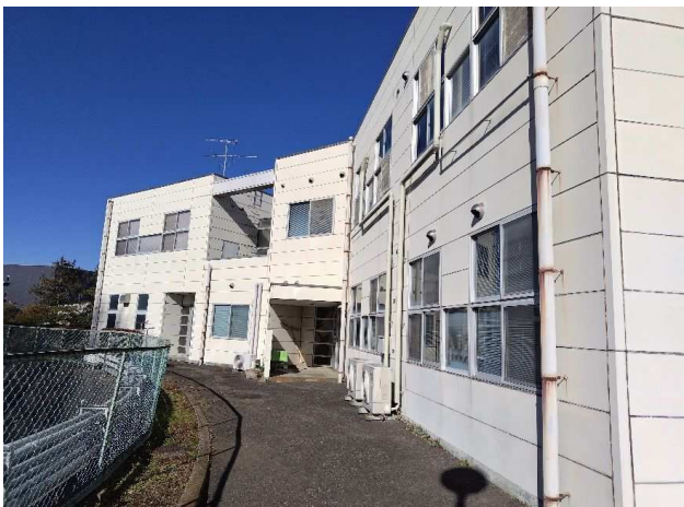
⑧ 特別作業 (クーラー配管)
