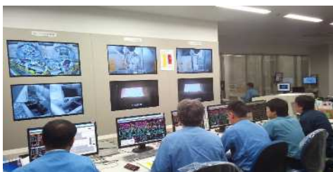
中央制御室 予備性能試験風景
