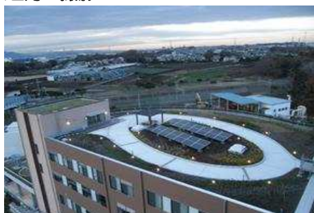
H30年11月 プラザ棟屋上
